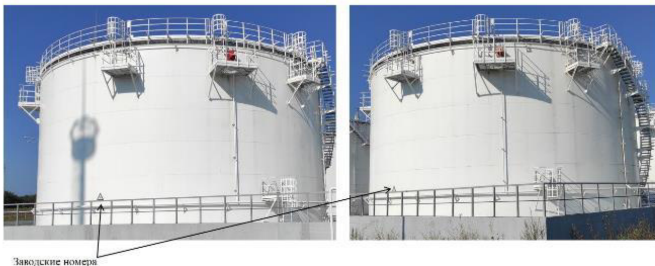
Рисунок 1 – Общий вид резервуаров стальных вертикальных цилиндрических РВСП-5000 с указанием мест нанесения заводских номеров
