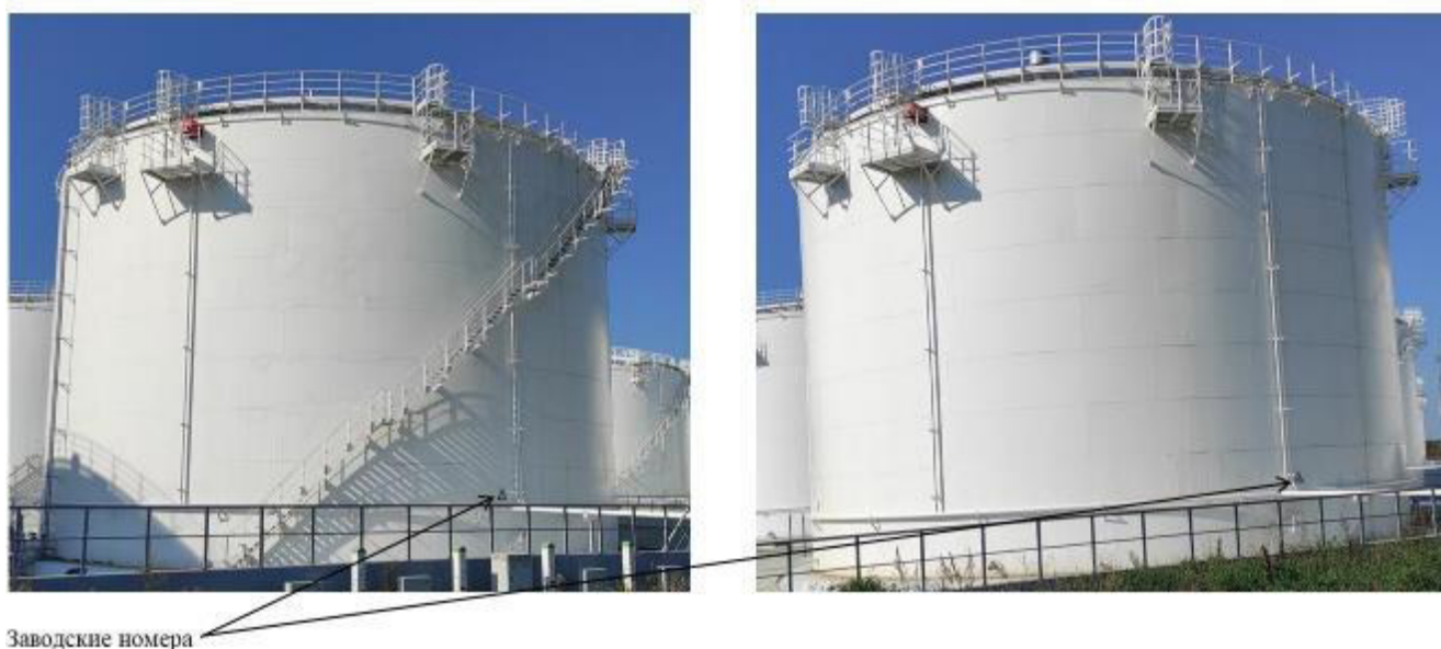
Рисунок 1 – Общий вид резервуаров стальных вертикальных цилиндрических РВС-10000 с указанием мест нанесения заводских номеров.
