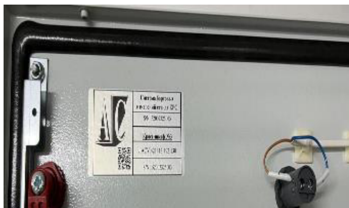
Рисунок 8 – Тыльная сторона дверцы кросс-шкафа 3 с информационной табличкой
