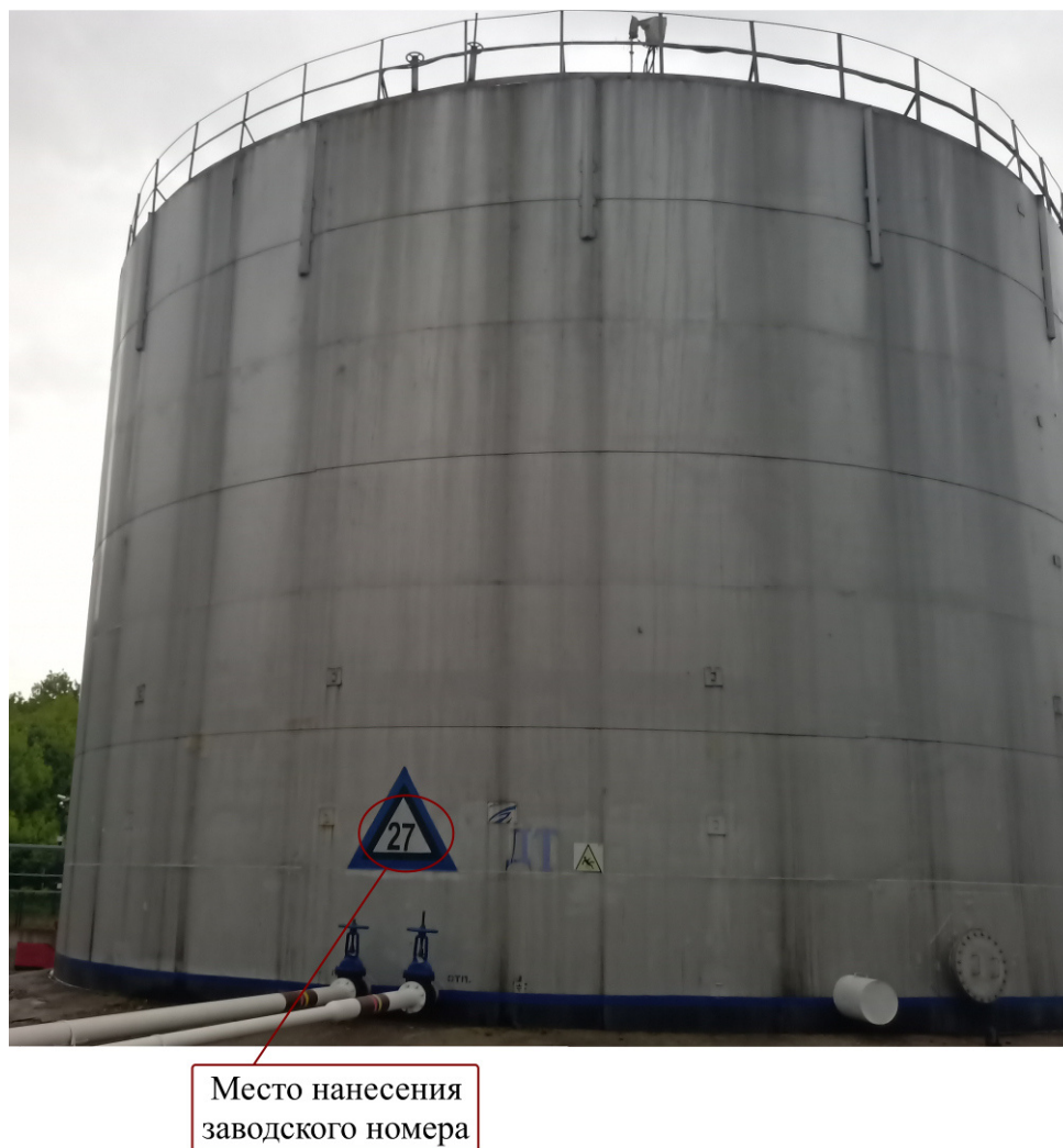
Рисунок 2 – Общий вид резервуара РВС-2000 №27 с указанием места нанесения заводского номера
